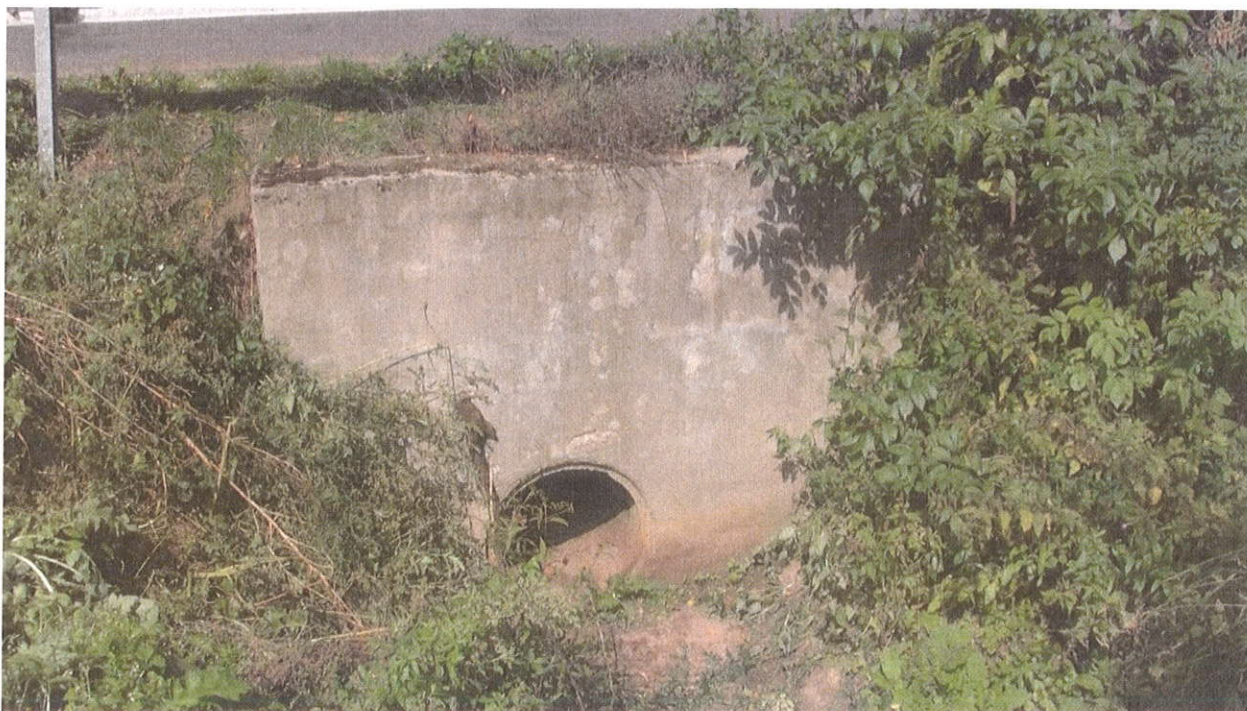
Zdjęcie wlotu przepustu
